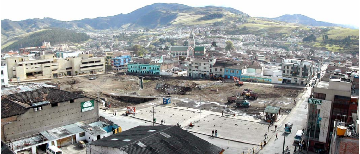
Avance de obra de la Plaza del Carnaval y la Cultura en mayo del 2.003
