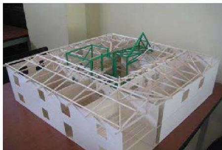
La estructura del proyecto es resuelta por medio del sistema combinado en el que los pórticos con diagonales resisten las cargas verticales y horizontales
