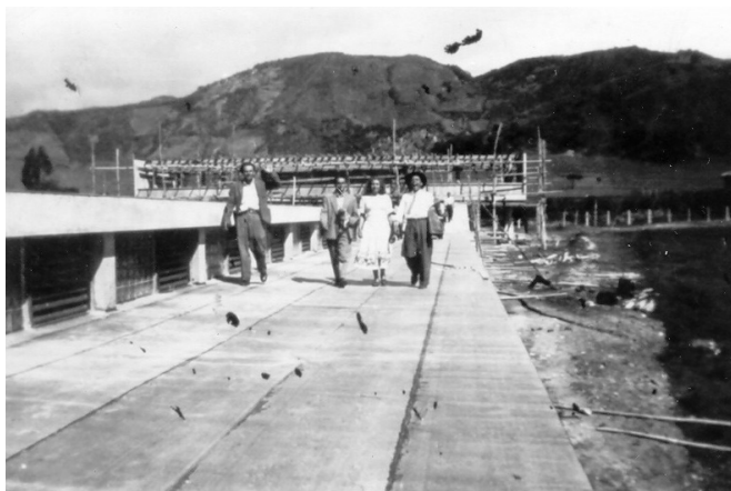
Fuente. Institución Educativa, Proceso de construcción 1930.
