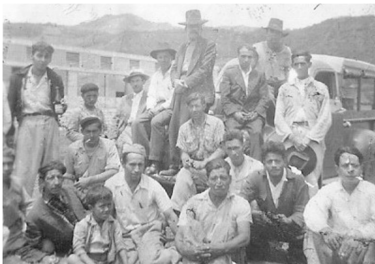
Fuente. Institución Educativa, proceso de construcción 1930.
