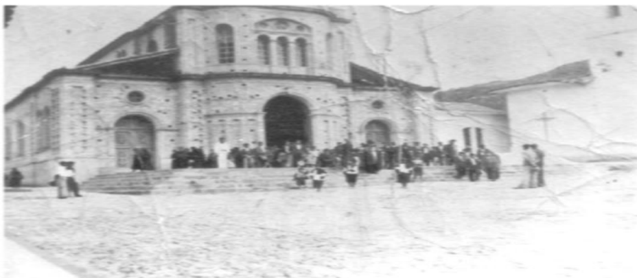
Figura 1. Construcción templo La Cruz
